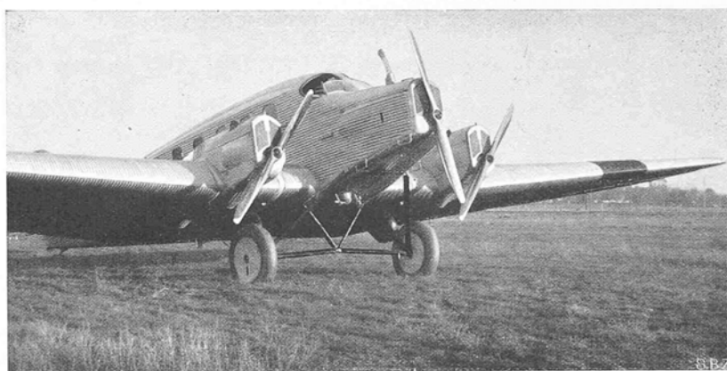
Abb. 15. Junkers G 24 wie oben, 3 \times 280/310 PS, SpW 28,5 m, L 15,2 m, G = 4300 + 2200 kg, 200 km/h, 9 Passagiere. Deutsche Lufthansa. Zürich-Stuttgart-Berlin, Genf-Basel-Frankfurt-Hamburg.
